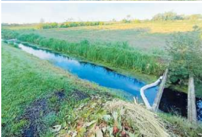
F.A. I rotoli di materiale assorbente posizionati lungo il canale Urian
