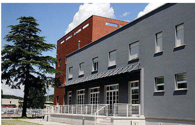
L'esterno della nuova struttura di accoglienza
